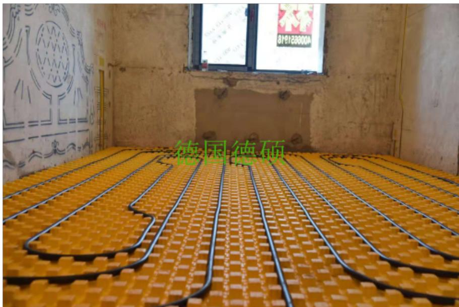
使用地暖早的客户，会发现地暖没有几年前热了；使用壁挂炉的客户，会发现交的天然气钱比以前多了。这就是地暖里水垢和生物粘泥附着在壁挂炉换热器和地暖管壁上了，水垢和淤泥会降低地暖管的导热系数，造成热量散不出来，地暖就没以前热了，壁挂炉也比以前费气了。我家是阻氧了，可是别人家不一定呀，我家的地暖是阻氧了，可其他家的地暖还是会有氧气进入呀。没错，其实供暖季只有100天左右，其余的260天是不供暖的，这260天才是地暖腐蚀结垢结生物粘泥的主要时间段。供暖的时候热力公司害怕对他的设备管道造成损害，使用的是软化水，并且会使用脱氧设备，这个时候是不太容易发生腐蚀和细菌繁殖的。但是供暖季一结束，各家的水就是死水了，腐蚀、细菌藻类的繁殖也就开始了，并且时间长达260天。这个时候如果你使用的是阻氧管，入户阀门一关，这些所有的损害都与你无关。
